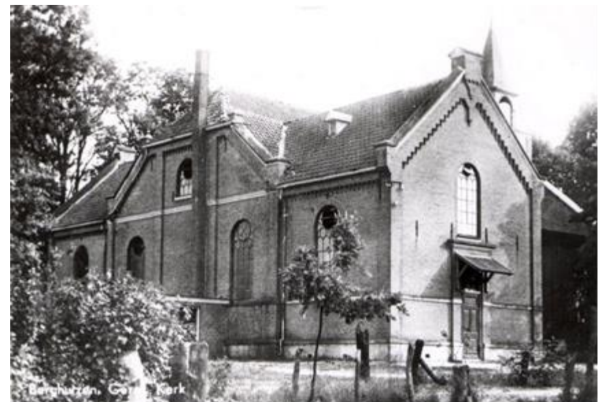
Kerk gebouw na 1912 met zijvleugels.
